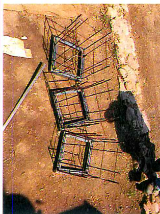
FABRICACION DE ARMADO PARA REGISTROS DE ELECTRICIDAD
