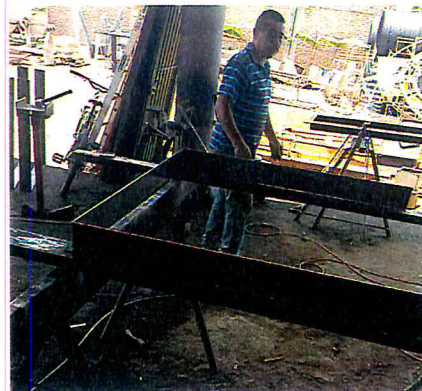
FABRICACION DE CAJETES DE SOLERA DE 4" PARA ARBOLES DEL ANDADOR
