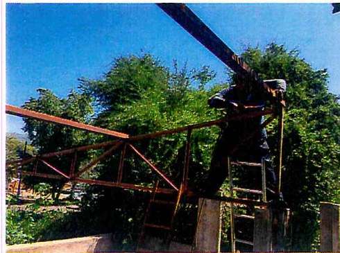
DESMONTAR ESTURCTURA DEL CRUCERO DE LA PUERTA DE BARRO
