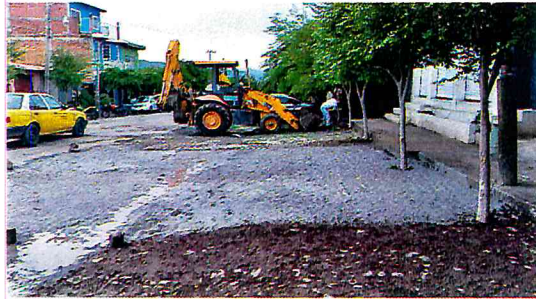
REEMPEDRADO JUTEADO CON CEMENTO CALLE OBREGON
