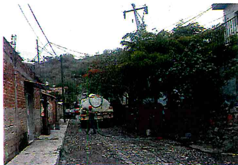
APOYO CON AGUA POTABLE A LA CALLE TLATELOLCO
