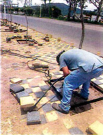
INSTALACION DE CAJETES DE SOLERA EN ANDADOR EN EL PASEO COMERCIAL
