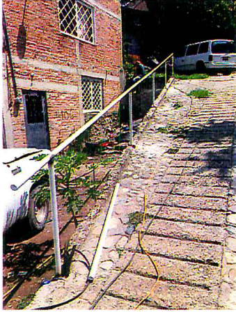
COLOCACION DE PASA MANO EN LA PRIV. CARMEN SERDA
