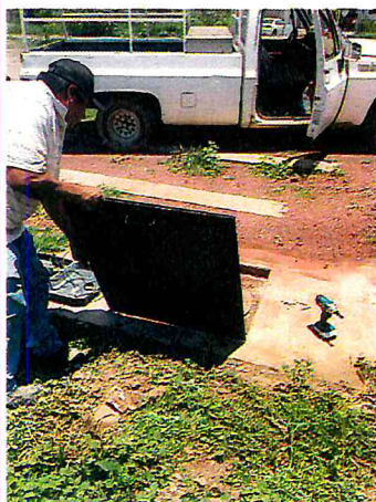
FABRICACION DE REGISTROS PARA CISTERNA
