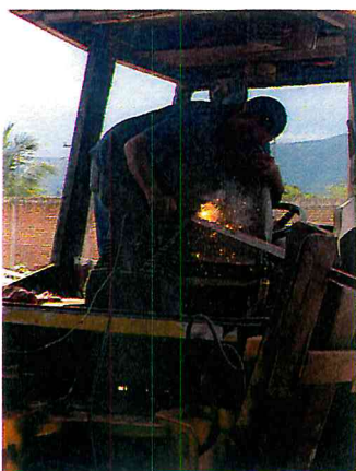
SOLDAR PALANCAS DE LA RETROEXCAVADORA DE OBRAS PUBLICAS
