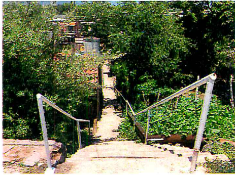
COLOCACION DE PASA MANO EN LA PRIV. XICOTENCATL
