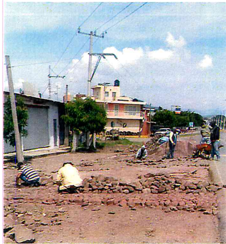
EMPEDRADO JUTEADO CON CEMENTO LATERAL DE CIRCUNVALACION ENTRE JAIME NUNO Y LUIS G. URBINA
