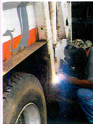
SOLDAR PERNOS DEL CAMION PRENSA DE SERVICIOS MUNICIPALES
