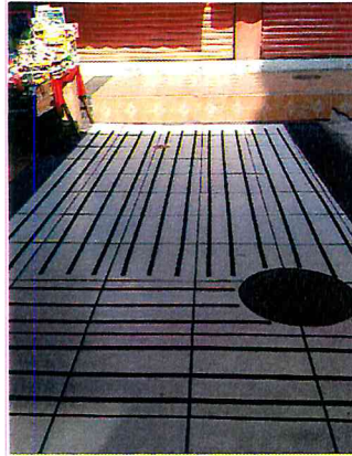
COLOCACION DE CINTA ANTIDERAPANTE EN EL MERCADO MUNICIPAL
