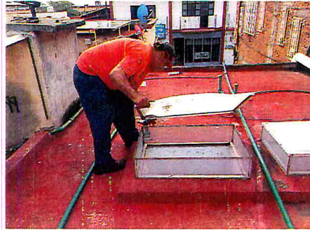
INSTALACION DE DOMOS Y SELLADO EN EL TECHO DEL MERCADO MUNICIPAL
