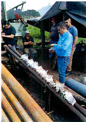
PERFORACION DE POZO PROFUNDO COL. VALLE DE EL GRULLO
