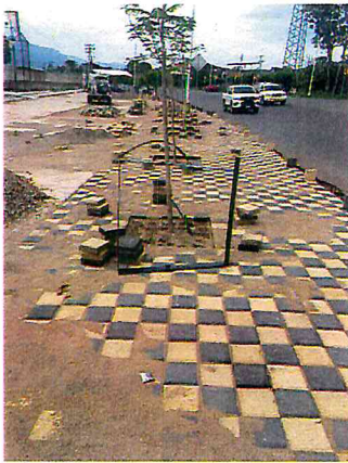
CONSTRUCCION DE ANDADOR FRENTE A LA UNIDAD DEPORTIVA
